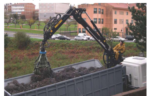
Grúa de reciclaje Recycling crane
